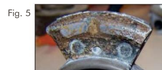
Placa de retén corroída
