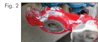
Présence de corrosion là où la peinture en poudre s'est écaillée
